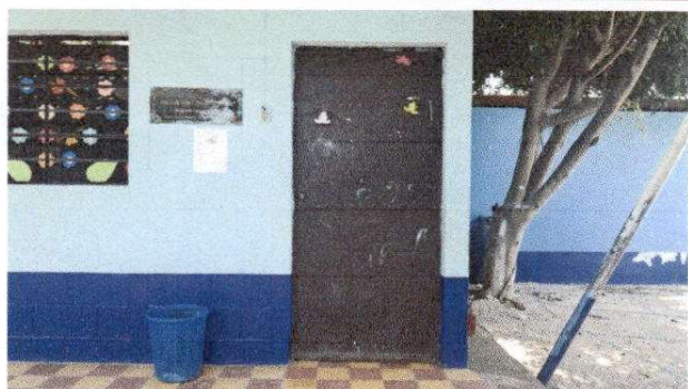
FOTO 3 : Sustitución de chapa
