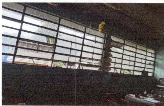
FOTO 4 : Sustitución de estructura de metal de ventana
