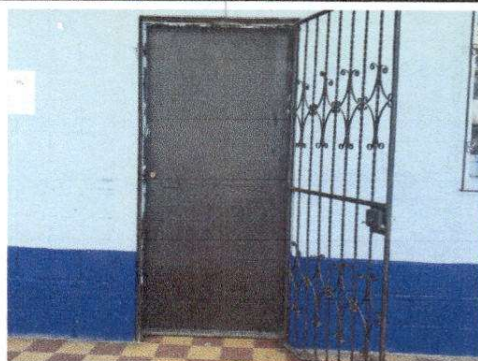
FOTO 2 : Mantenimiento de estructura (lijado, cambio de tubo, cepillado sujecciones, aplicación de pintura)
