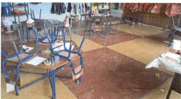
FOTO 5 : Sustitución de piso de cemento líquido
