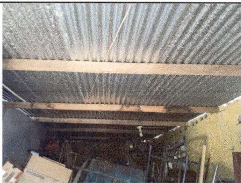
FOTO 1 : Sustitución de lámina, por lámina troquelada aluzinc calibre 26 y sustitución de estructura de madera por metal
